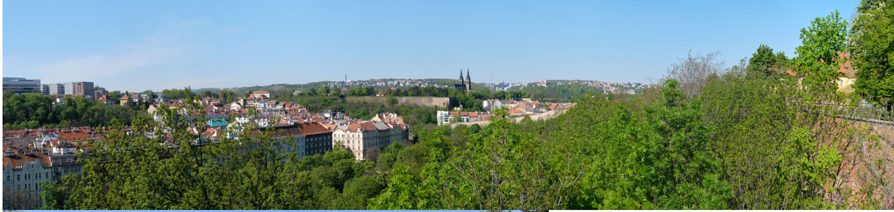
4.12 POHLED ZE SEVERNÍHO PŘEDPOLÍ NUSELSKÉHO MOSTU
