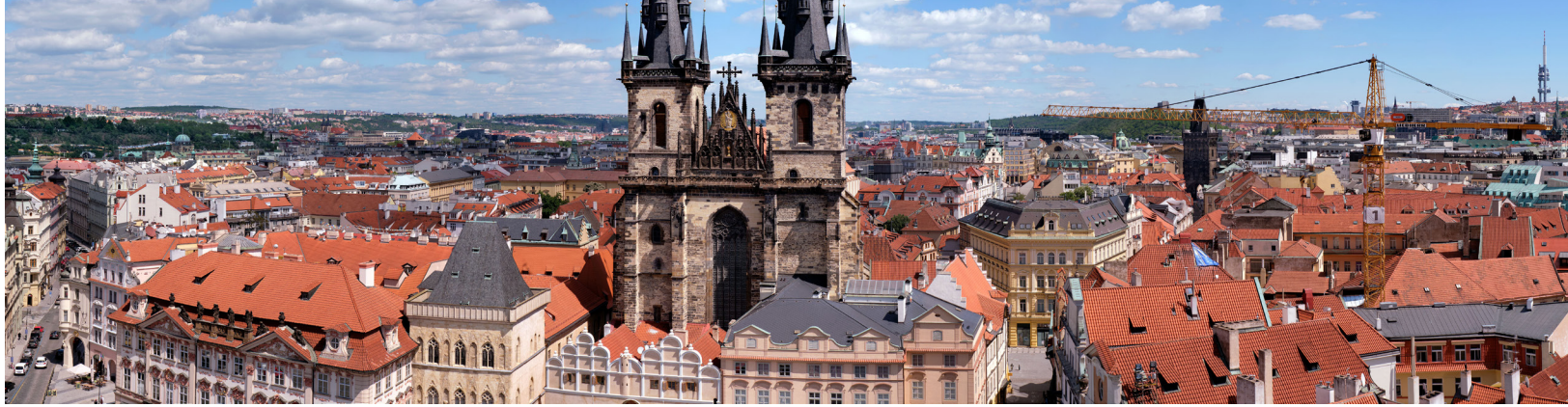
3.03 POHLED Z VĚŽE STAROMĚSTSKÉ RADNICE NA VÝCHOD
