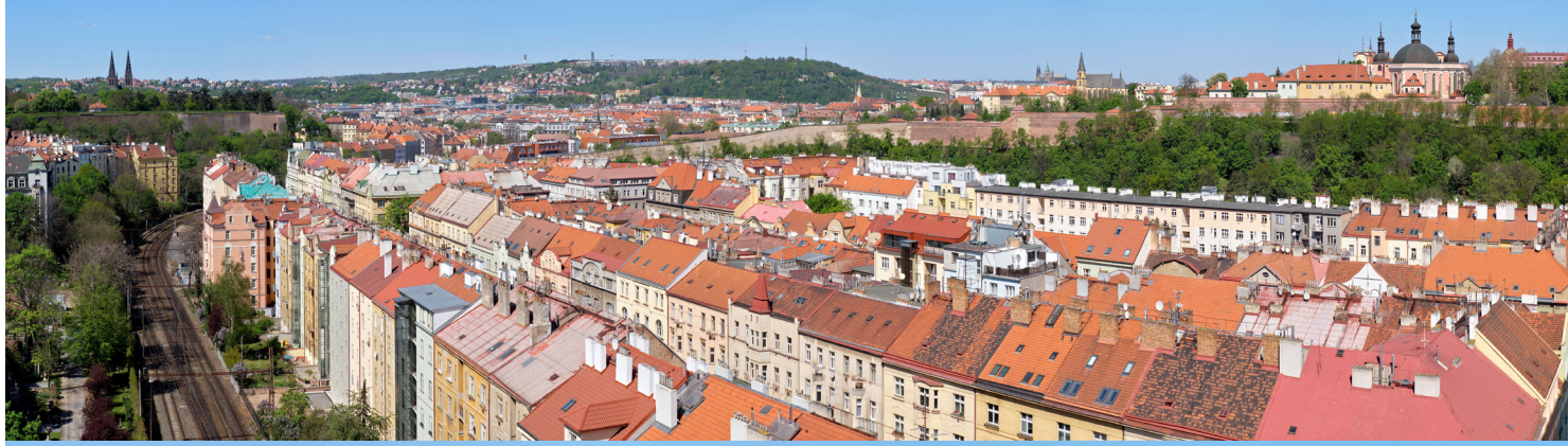
4.11 POHLED Z JIŽNÍHO PŘEDPOLÍ NUSELSKÉHO MOSTU
