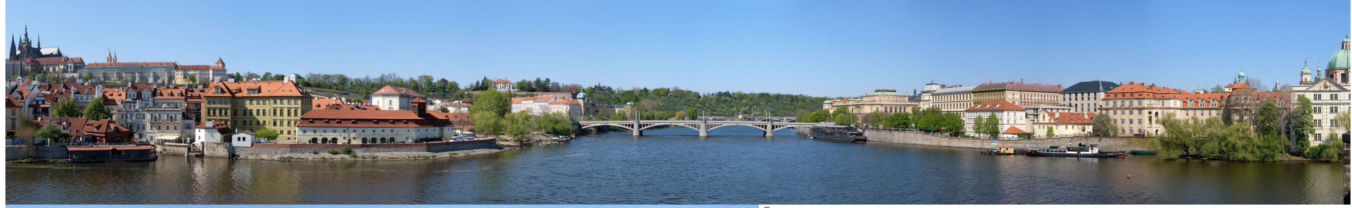
5.04 POHLED Z KARLOVA MOSTU PO PROUDU
