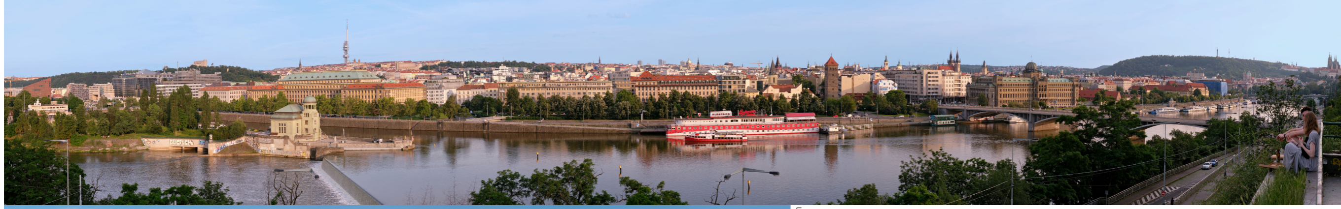
4.01 POHLED OD RESTAURAČNÍHO PAVILONU PRAHA - EXPO 58
